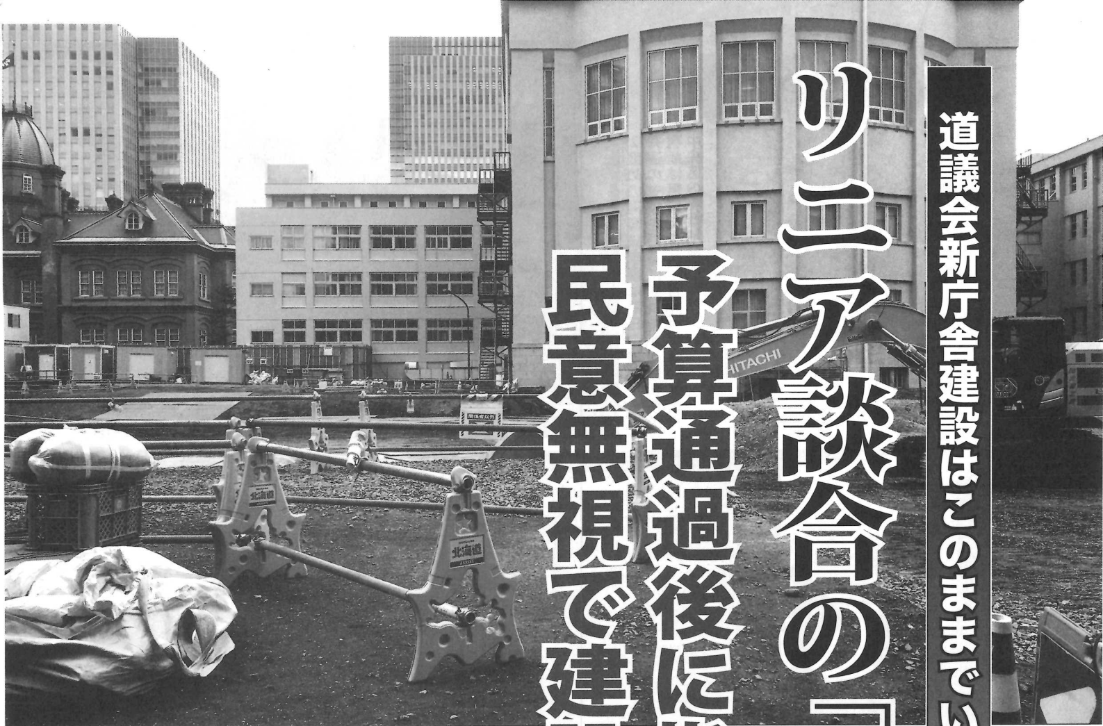
始まった新庁舎の建設工事(右上の建物が現在の議会庁舎)
