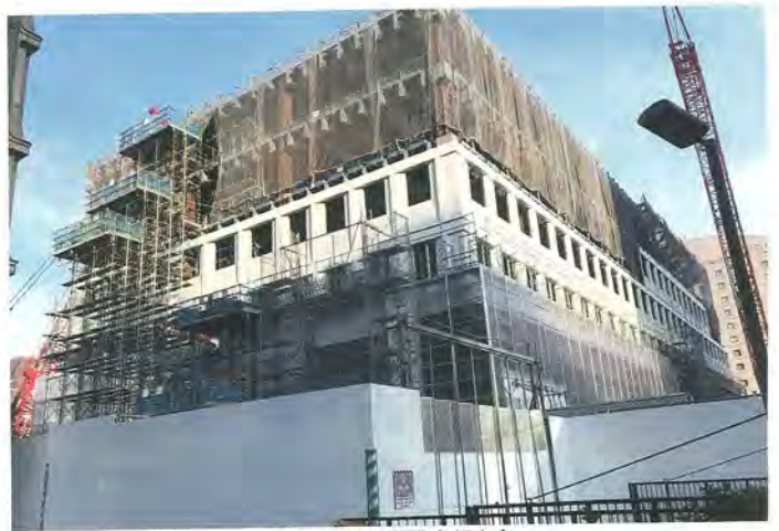
▲建設中の道議会新庁舎
